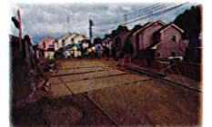
▲新ホーム建設予定地
